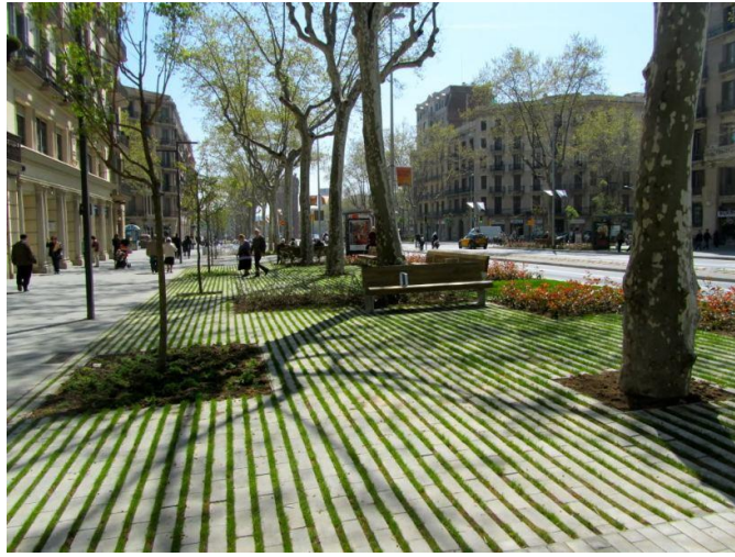
Imatge 5. Exemple de paviment permeable amb arbres i bancs al Passeig de Sant Joan de Barcelona. Font: José Elías Bonells.
