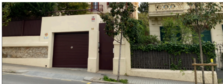
exemple de convivència de diferents tipus de tanques
