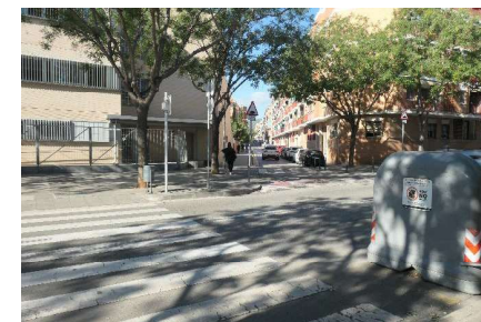
Pas de vianants accessible a c. Pablo Picasso – c. Antoni Gaudí, on a més hi ha un pas de vianants elevat per marcar l'accés a àmbit pacificat
