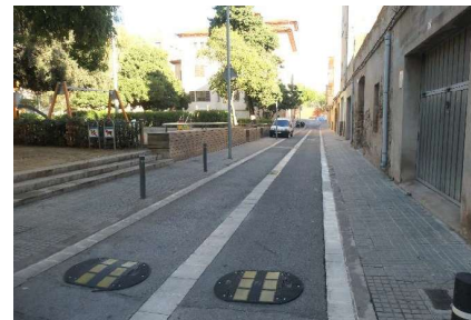
Carrer Ebre, amb plataforma de paviment únic
