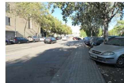
C. Josep Torras i Bages, places d'aparcament en semibateria de zona blava buides i a la dreta bossa d'aparcament sense pavimentar amb ocupació elevada
