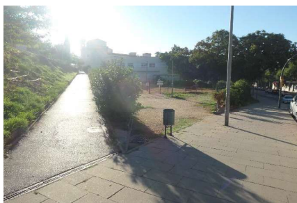
Rampa de connexió de la vorera de Pablo Picasso amb el carrer Sant Benito Menni
