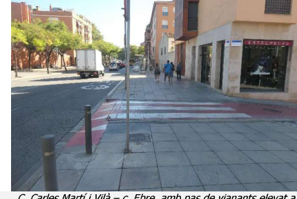
C. Carles Martí i Vilà – c. Ebre, amb pas de vianants elevat a l'accés
