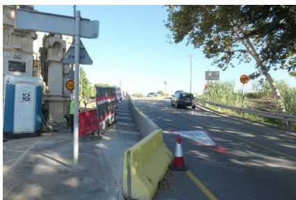
Carrer del Doctor Antoni Pujadas, cruïlla amb la BV-2002. Aquest punt està en obres d'urbanització de la vorera i talús de la carretera BV-2002 PK 6+800, Carrer del Dr. Antoni Pujadas a Sant Boi de Llobregat
