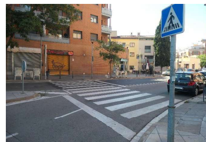
Pas de vianants accessible a c. Riera Basté- pl. Pallars Sobirà, amb franja de detecció per a invidents
