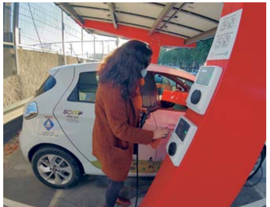
La nueva fotolinera refleja la apuesta de Sant Boi por el uso de fuentes de energía renovables y por un modelo de movilidad eléctrica y sostenible
