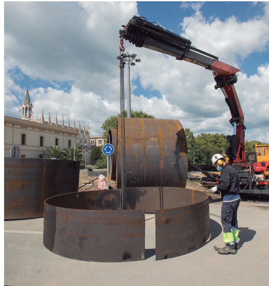
Los daños en la infraestructura del canal de la Dreta provocaron la caída del firme
