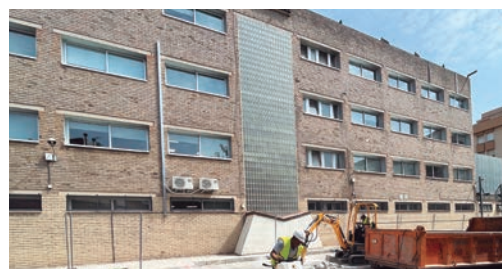
Obras de ampliación en el CAP Montclar
