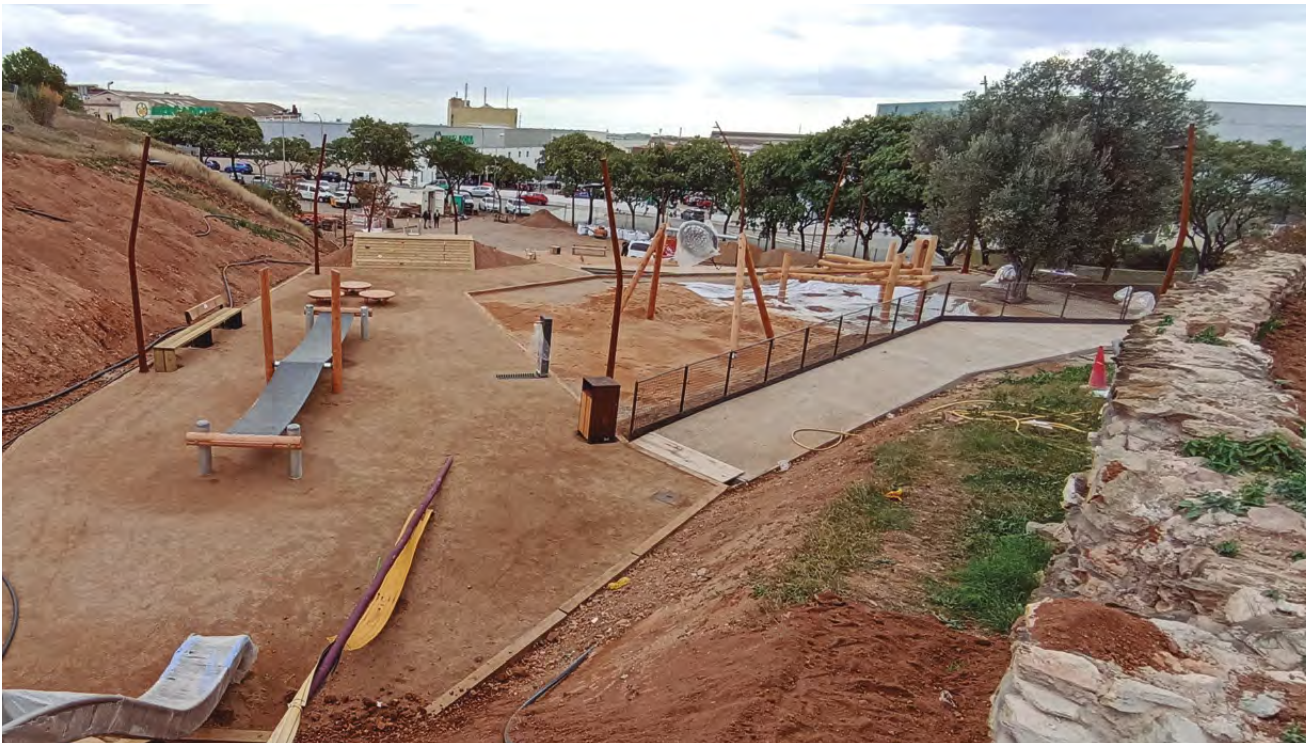
Les obres de la primera fase del projecte, cofinançat per l'Ajuntament i la Unió Europea, estan en la recta final
