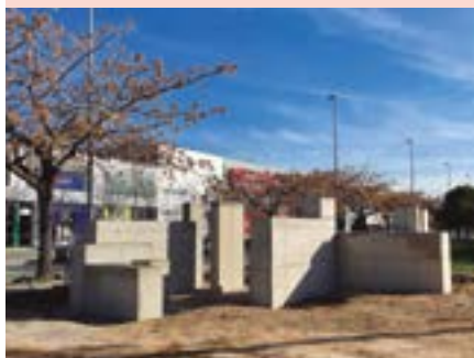
Arriba, jóvenes durante la fase de diseño del circuito. Sobre estas líneas, estado actual de las obras
