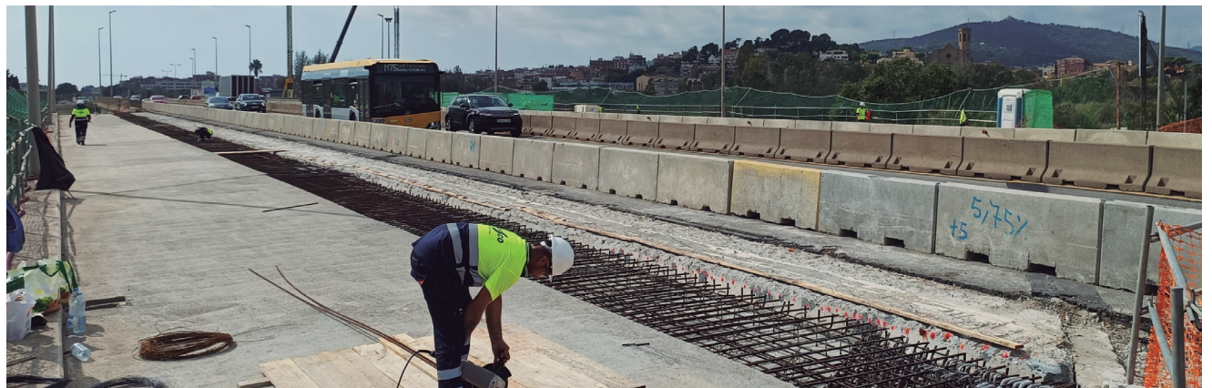
Avances en las estructuras de ampliación del puente
