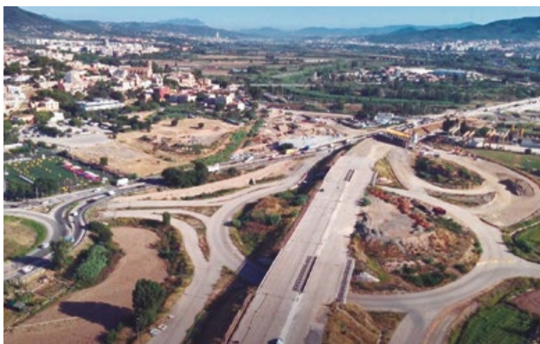
Vista aérea del avance de las obras de la futura B25
