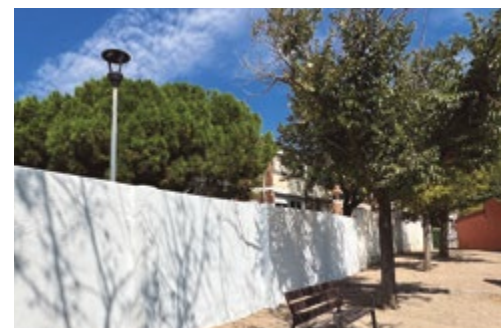
Escola Montbaig: reforç i pintura del mur
