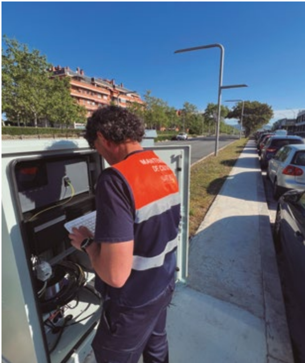
Les fuites es poden detectar amb aquest dispositiu
