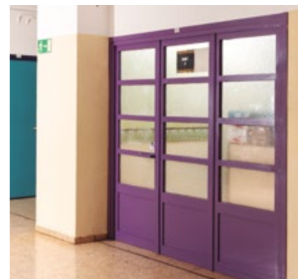
Como otros años, se hacen trabajos de pintura y mantenimiento en las escuelas
