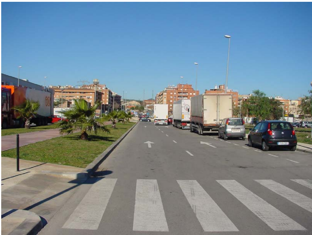
VISTA GENERAL DEL C/ ALACANT EXECUTAT
