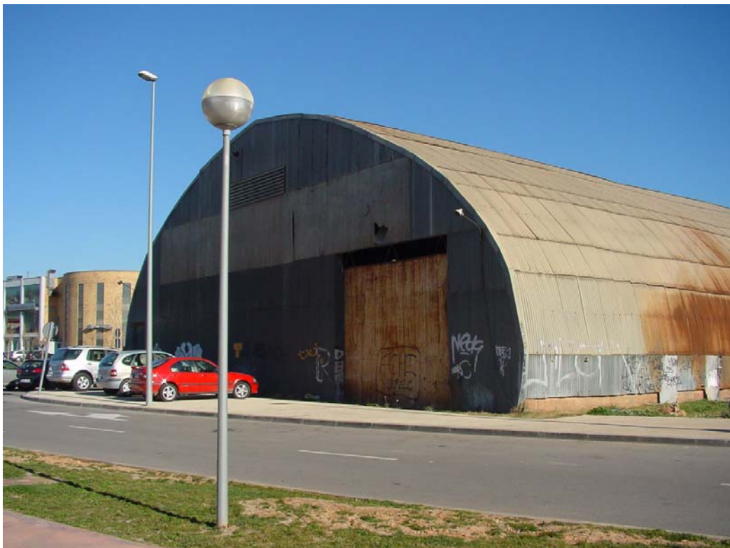
EDIFICACIÓ TIPUS "HANGAR" SITUADA A LA ZONA VERDA
