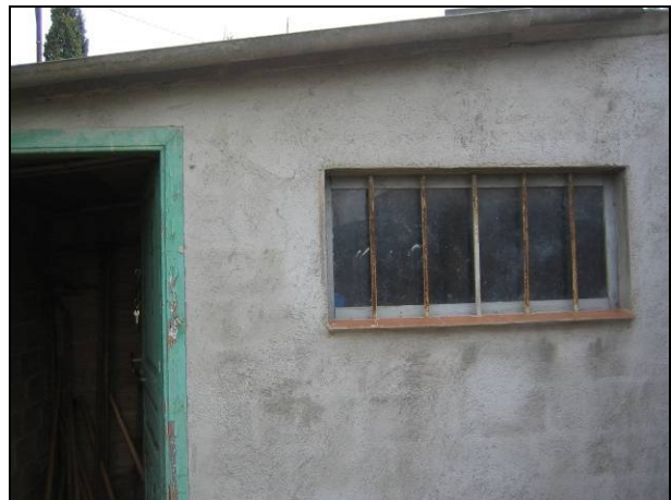
Vista general d'un dels magatzems.
