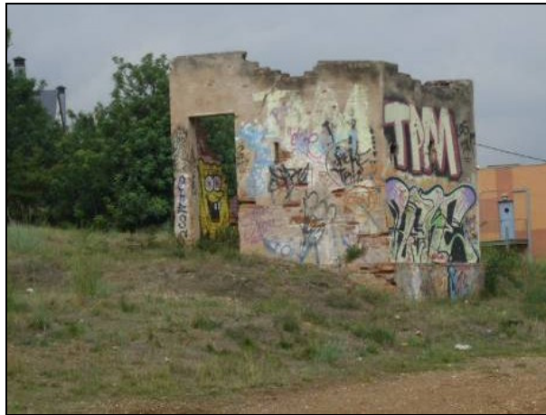
Vista general de la construcció.
