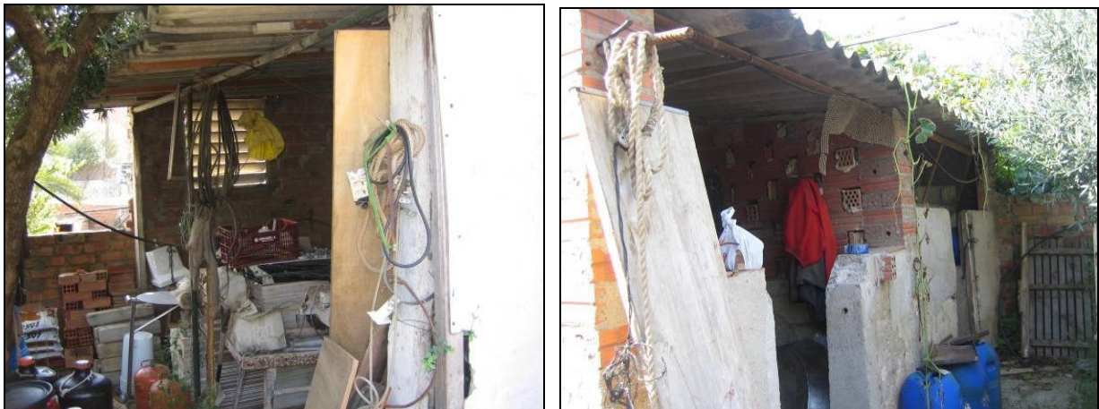
Detall de les construccions d'obra.
