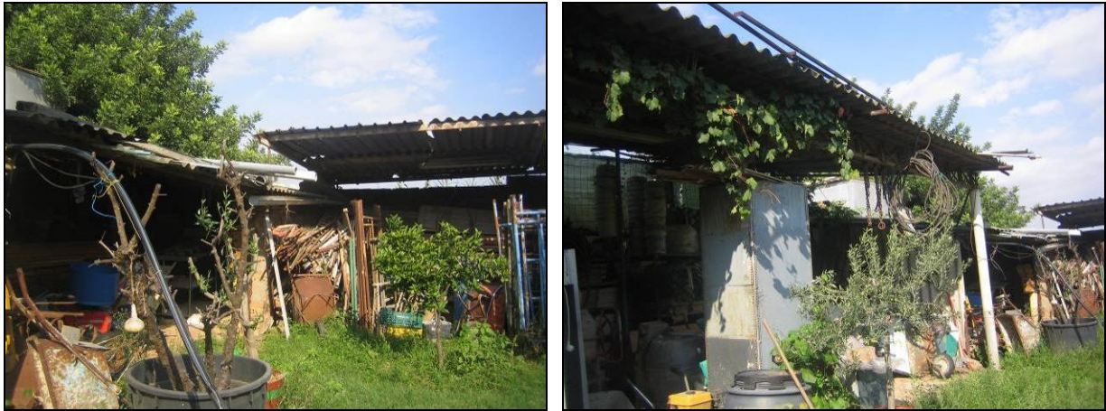
Detall dels coberts amb pilars metàl·lics.
