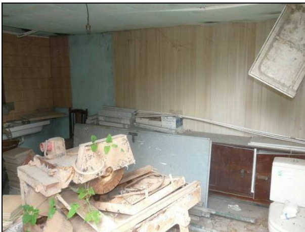
Detall de l'interior de la construcció.
