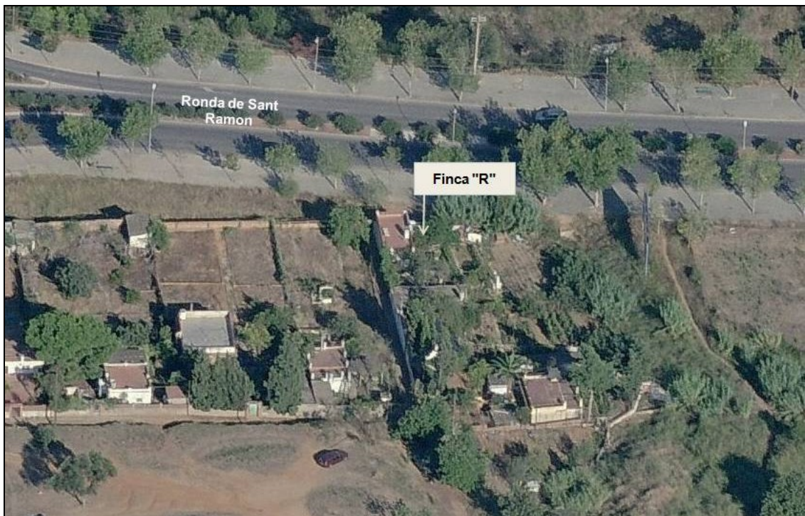
Fotografia aèria de la Finca R.
